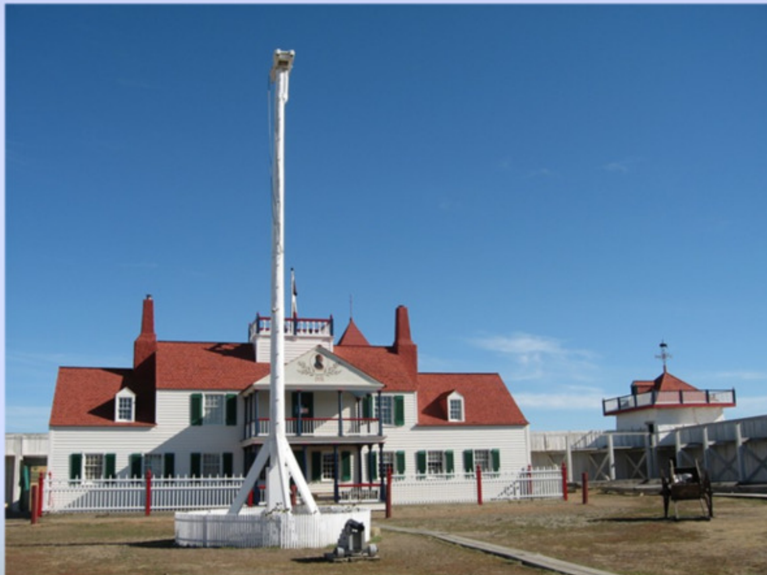
le bâtiment principal
